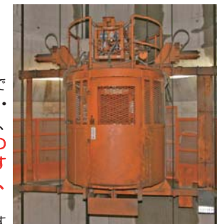
エレベータ（主立坑）
